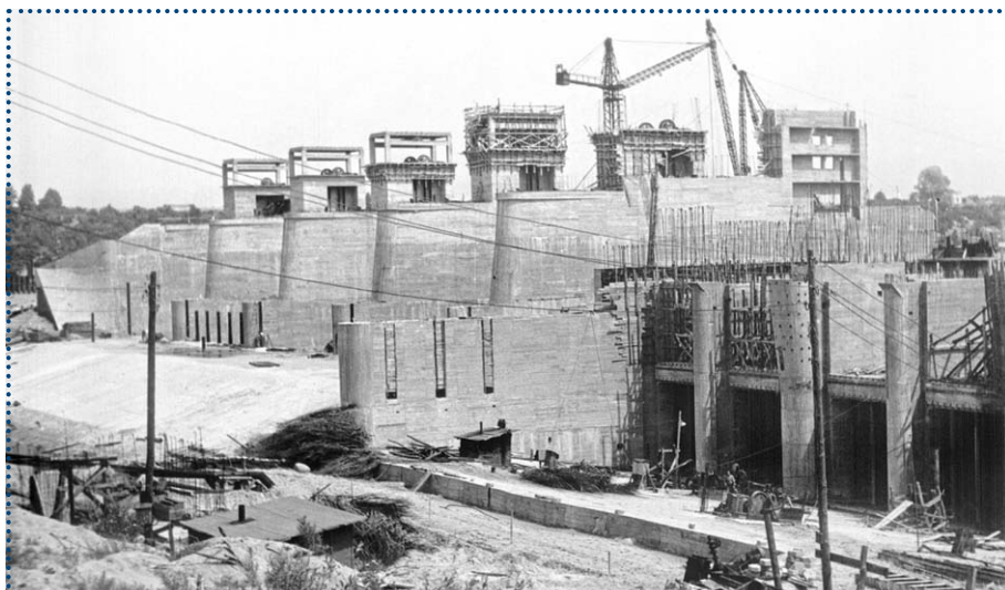
Fot. 1. Budowa zapory wodnej w Dębem
